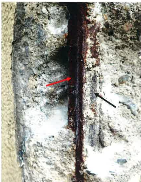
Obrázek č. 47: Typická koroze rohových prutů v táhlech – koroduje zejména část povrchu výztuže při vnějším povrchu táhla, zbylý povrch výztuže v masě táhla je v podstatě bez koroze
