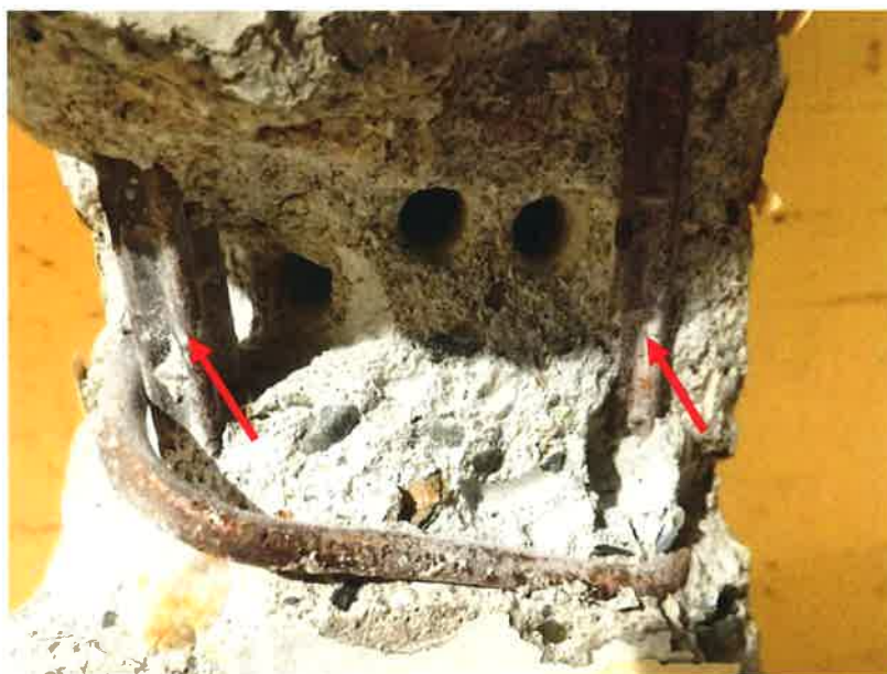
Obrázek č. 37: Sekaná sonda na podhledu ztužidla mezi 3. a 4. příčným ztužidlem
