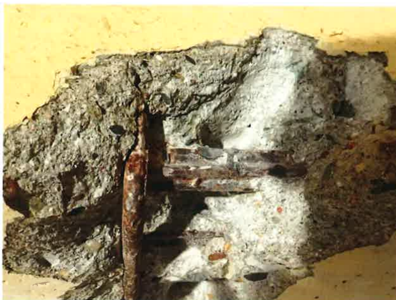
Obrázek č. 40: Sekaná sonda na podhledu 2. podélníku zprava při 3. příčniku od OP1 – patrný je stav a tvar výztuže
