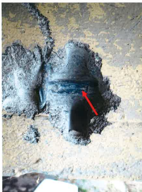
Obrázek č. 44: Sekaná sonda k ověření druhé vrstvy výztuže na 2. příčniku od OP2
