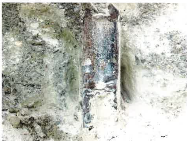
Obrázek č. 48: Typický stav mezilehlých prutů výztuže – nízká nebo zcela žádná míra koroze
