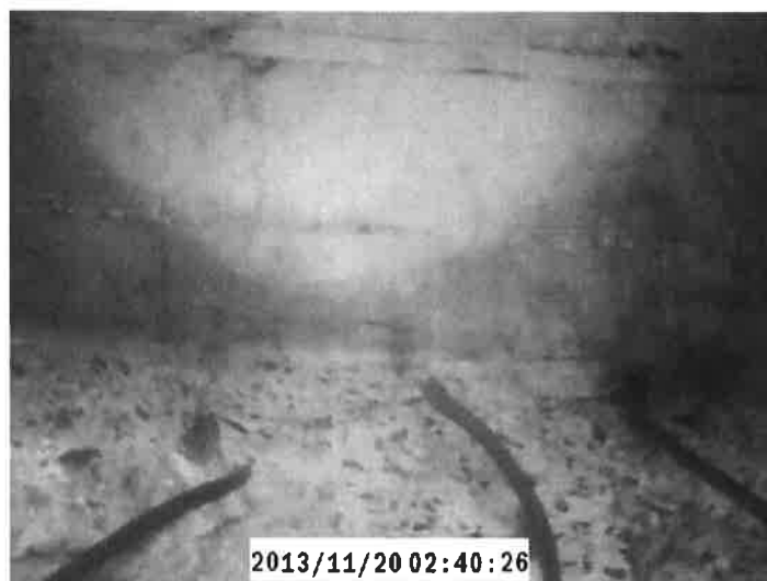
Obrázek č. 49: Porucha stěny oblouku
