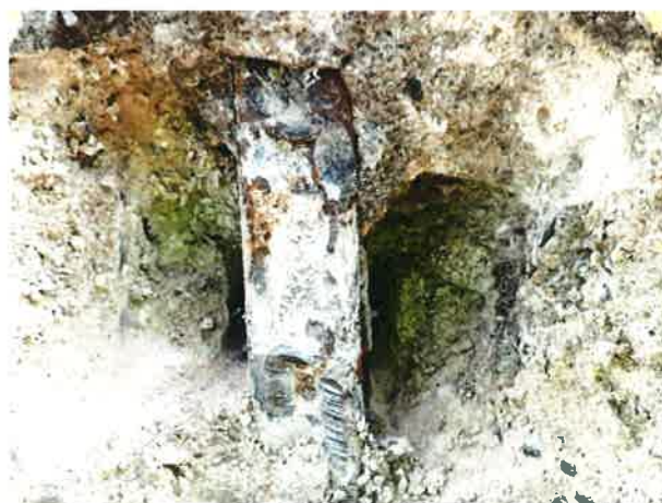
Obrázek č. 48: Typický stav mezilehlých prutů výztuže – nízká nebo zcela žádná míra koroze
