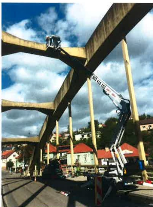
Obrázek č. 5: Provádění diagnostických prací z pracovní plošiny umístěné na mostě
