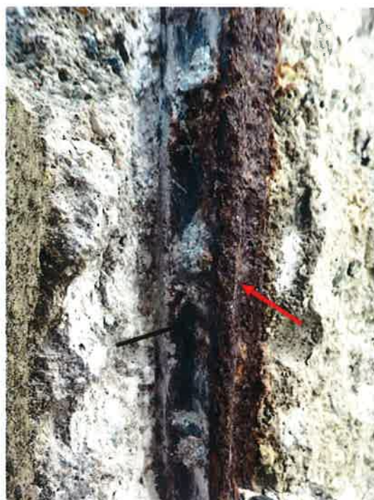
Obrázek č. 47: Typická koroze rohových prutů v táhlech – koroduje zejména část povrchu výztuže při vnějším povrchu táhla, zbylý povrch výztuže v masě táhla je v podstatě bez koroze
